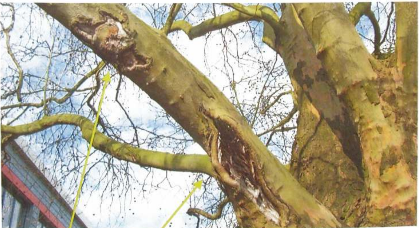
Foto 3: Anfahrtschaden und gebrochener Ast
